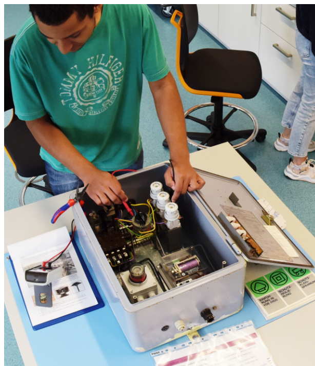
Abbildung 7: Spannungsfreie Durchgangsmessungen am Sirenschaltkasten
