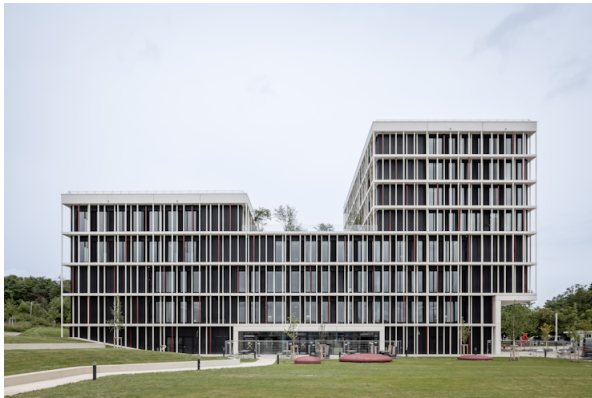
Abbildung 2: Lehrgebäude (Südfassade) und Campuswiese Foto: Rainer Taepper Architekturfotografie
